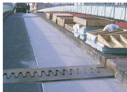
珪砂散布後の補強完了状況
