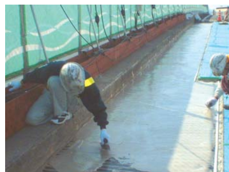
上層樹脂モルタルの敷設
