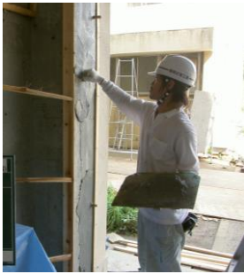
1. 下地調整状況
