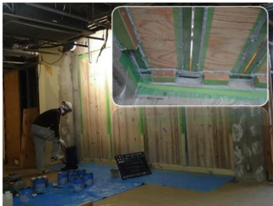
4. エポキシ樹脂注入状況
