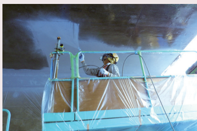
▲ネオライナーEX 施工状況
