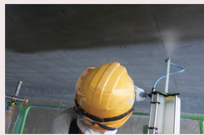
▲ネオプライマーEX(速乾型)施工状況
