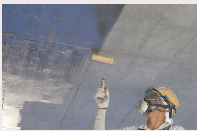
▲ネオプライマーEX 施工状況
