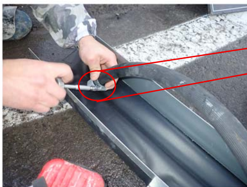
写真-8 排水継手とホースの固定
