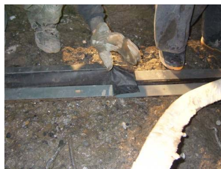
写真-4 継手部の施工（止水ゴムの重ね合わせ）
