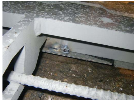
写真-6 組立て溶接
