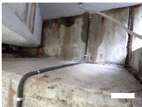
写真-10 ホース固定完了
