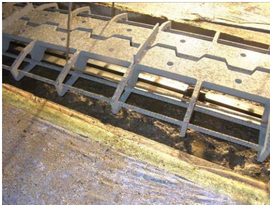
写真-5 伸縮装置設置
