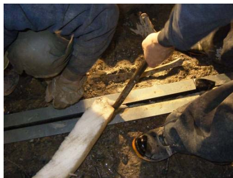
写真-3 バックアップ材の挿入
