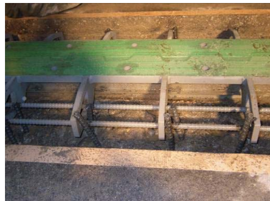
写真-7 伸縮装置への固定完了
