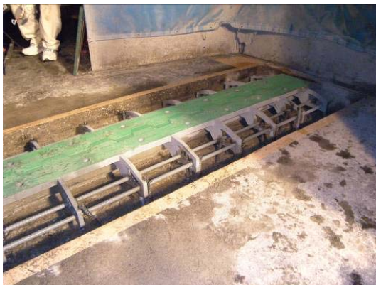
写真-7 伸縮装置への固定完了
