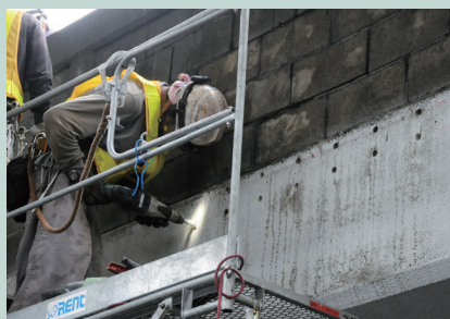
▲アンカー孔削孔
