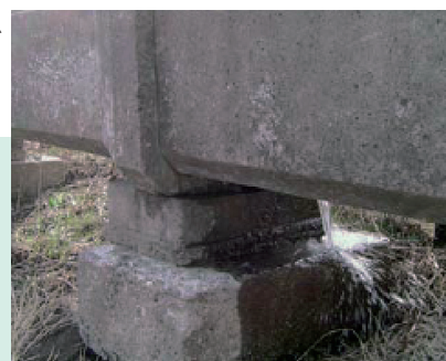
完成▲ 二次製品用水路の目地部からの漏水▶
