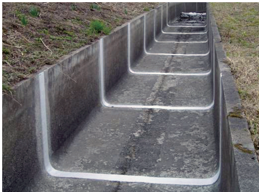
完成▲ 二次製品用水路の目地部からの漏水▶
