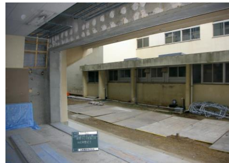
下地調整完了
