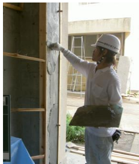
下地調整状況
