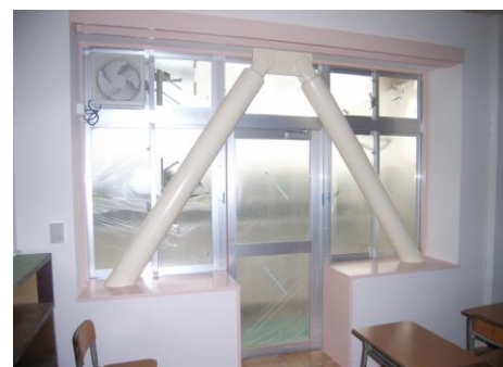
完 成(出入口開口付)
