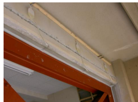
注入樹脂のオーバーフロー状況
