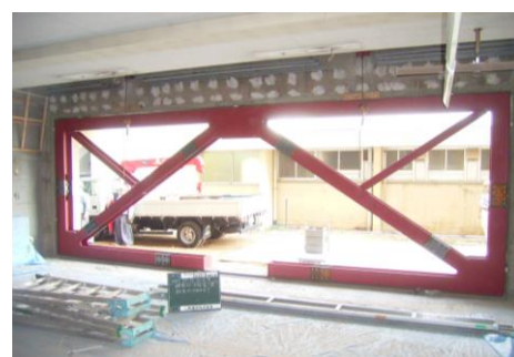
鉄骨建方完了
