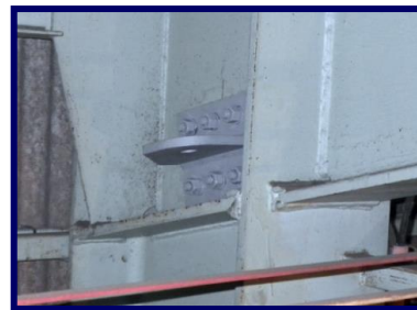
1. 定着金具取付(ボルト接合)
