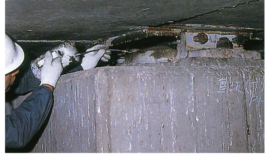
▲潤滑性防錆剤注入
