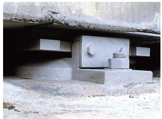
▲金属溶射完了
