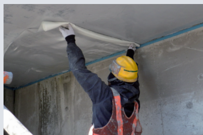
▲ネオライナーEXシート貼付け状況
