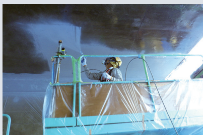
▲ネオライナーEX 施工状況
