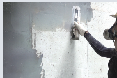
▲ネオプライマーEX Plus+ 施工状況
