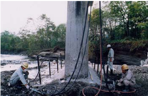
▲橋脚フーチング下部
