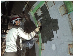
② プライマー塗布
