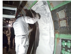
④ シート貼付け・ 接着剤含浸
