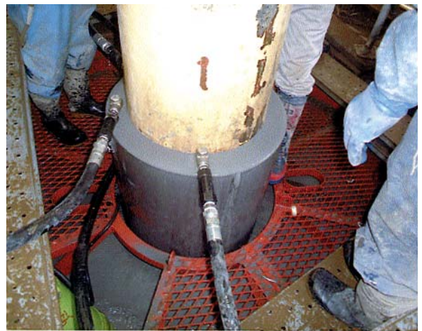
無収縮モルタル充填状況
