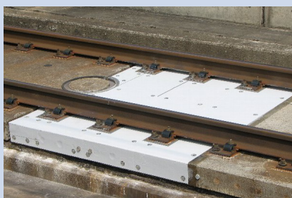
▲ 軌道スラブの水掛かり防止対策
