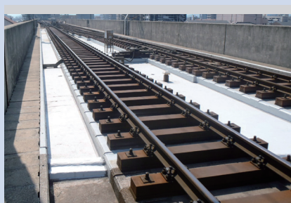
▲ 鉄道橋上部工の防水対策
