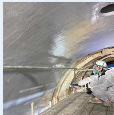
▲ 中塗施工状況
